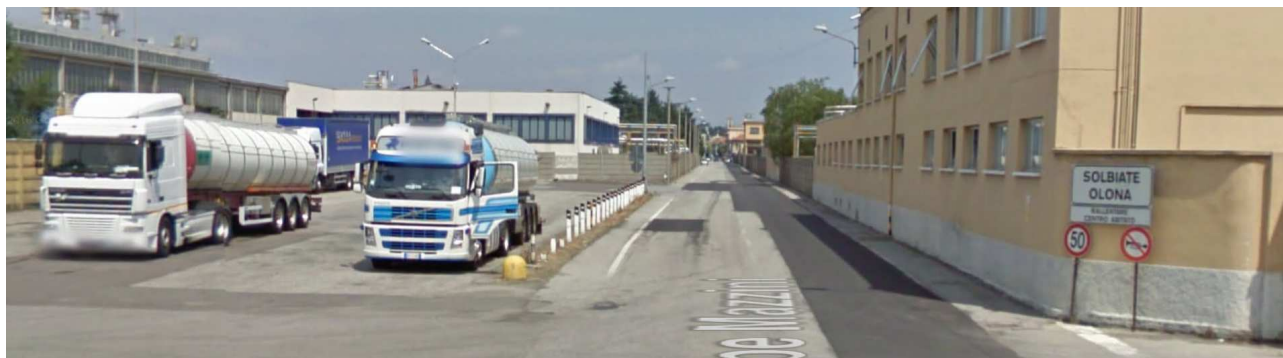
Piazzale parcheggio autobotti lungo la strada comunale – Via Mazzini
